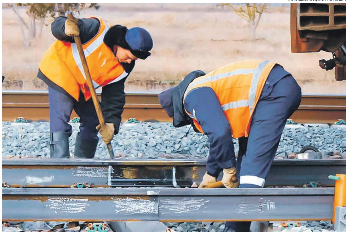
Фото Дорпрофжел на КбшЖД
