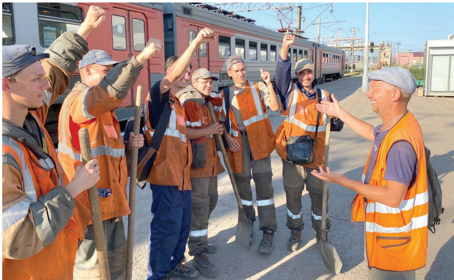
Ребята из студенческого строительного отряда «Волжане» трудились на перегоне Янталь — Лена
